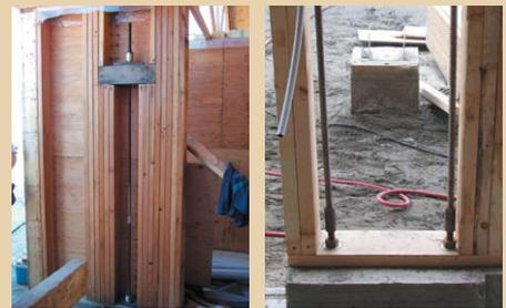
내진설계용 Seismic Rod가 시공된 모습
